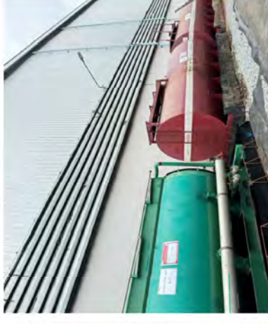
ถังรองรับน้ำเสียจากกระบวนการล้างทำความสะอาด สะสม(Storage Tank)
